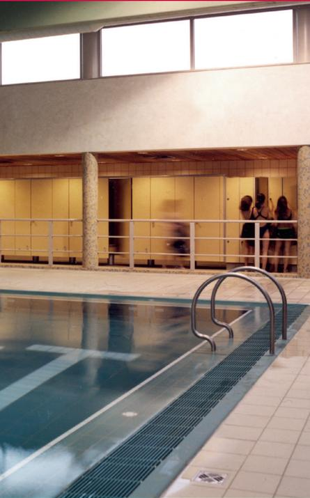
Les cabines sont assemblées dans un ensemble très stable à l'aide de tous les renforcements, fixations et supports en matériaux inoxydables indispensables, nécessitant un minimum d'entretien. Panneaux décoratifs stratifiés haute pression, autoportants et massifs, fabriqués à base de résines synthétiques thermodurcissables renforcées d'une façon homogène par des fibres de cellulose. Couche de finition en mélamine double face. Épaisseur des panneaux = 13 mm. Chaque ensemble est réalisé sur mesure.
