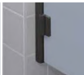
Montant aluminium de même hauteur de la porte
